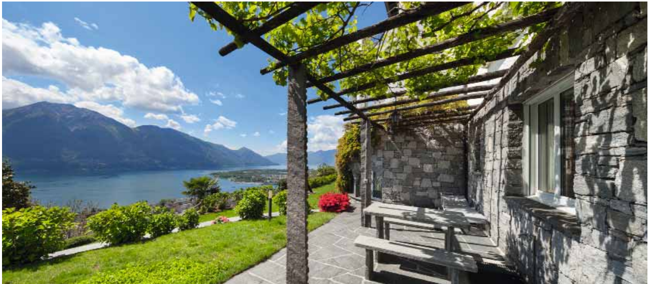
Tessiner Pergola mit Weinreben begrünt; Bodenbelag aus Gneis, polygonal verlegt
